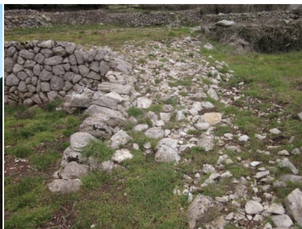
Slika 9.2.1.14. Svladavanje visinskih razlika između terasa je riješeno kamenim stazama
