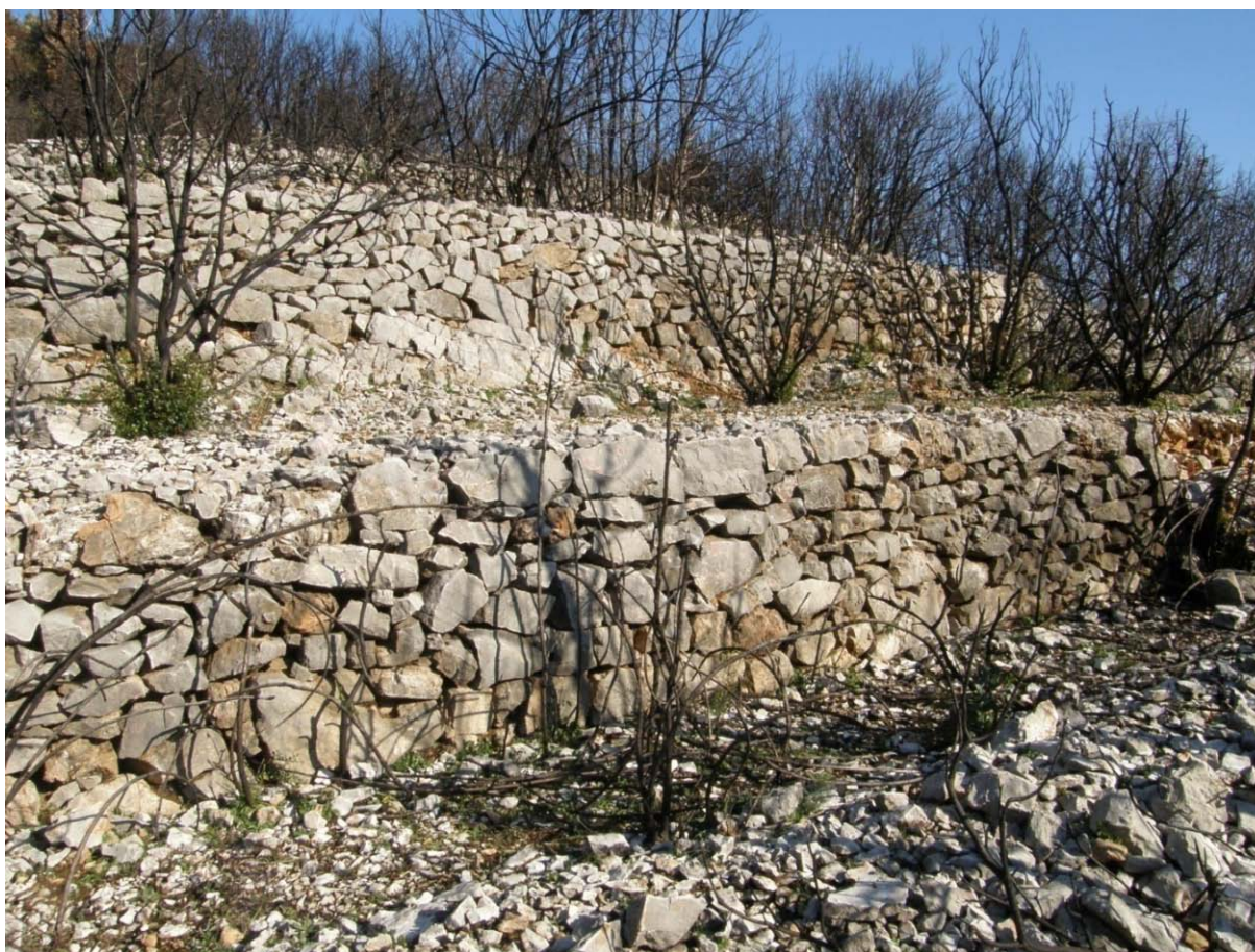
Slika 9.1.1.8. Detalj slaganja podzida sa krupnijim vapnenačkim kamenjima
