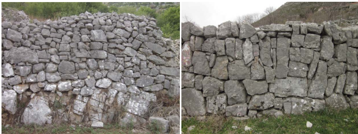
Slike 9.3.1.12. i 9.3.1.13. Način slaganja kamenja na terasama kombiniranjem sitne i velike granulacije (lijevo), te slaganje pravilno isklesanih kamenja uz cestu koja vodi do naselja(desno)
