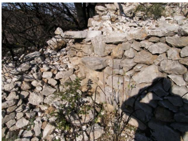
Slika 9.1.1.9. Interpolacija skala u podzidu
