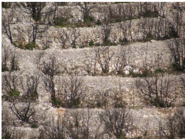
Slika 9.1.1.6. Detalj slaganja kamenja
