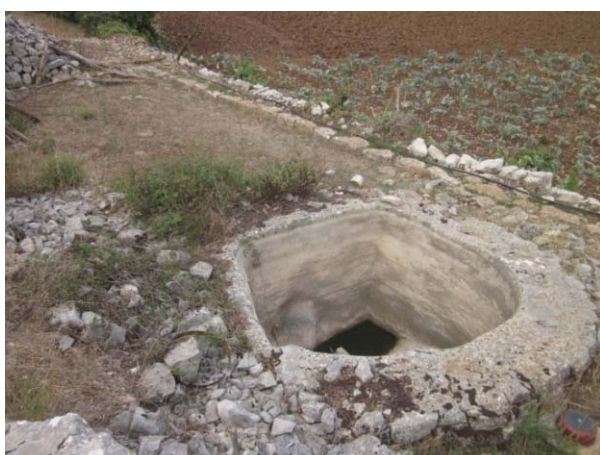
Slika 9.3.1.20. U dolu se nalazi nedavno izgrađeni puč koji je obložen betonom
