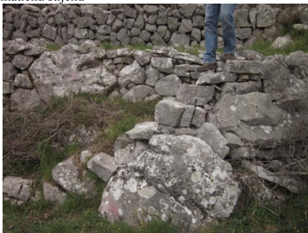
Slike 9.3.1.10. i 9.3.1.11. Interpolacija skala na postojećim stijenama (lijevo), te konzolno u podzidima terasa (desno)
