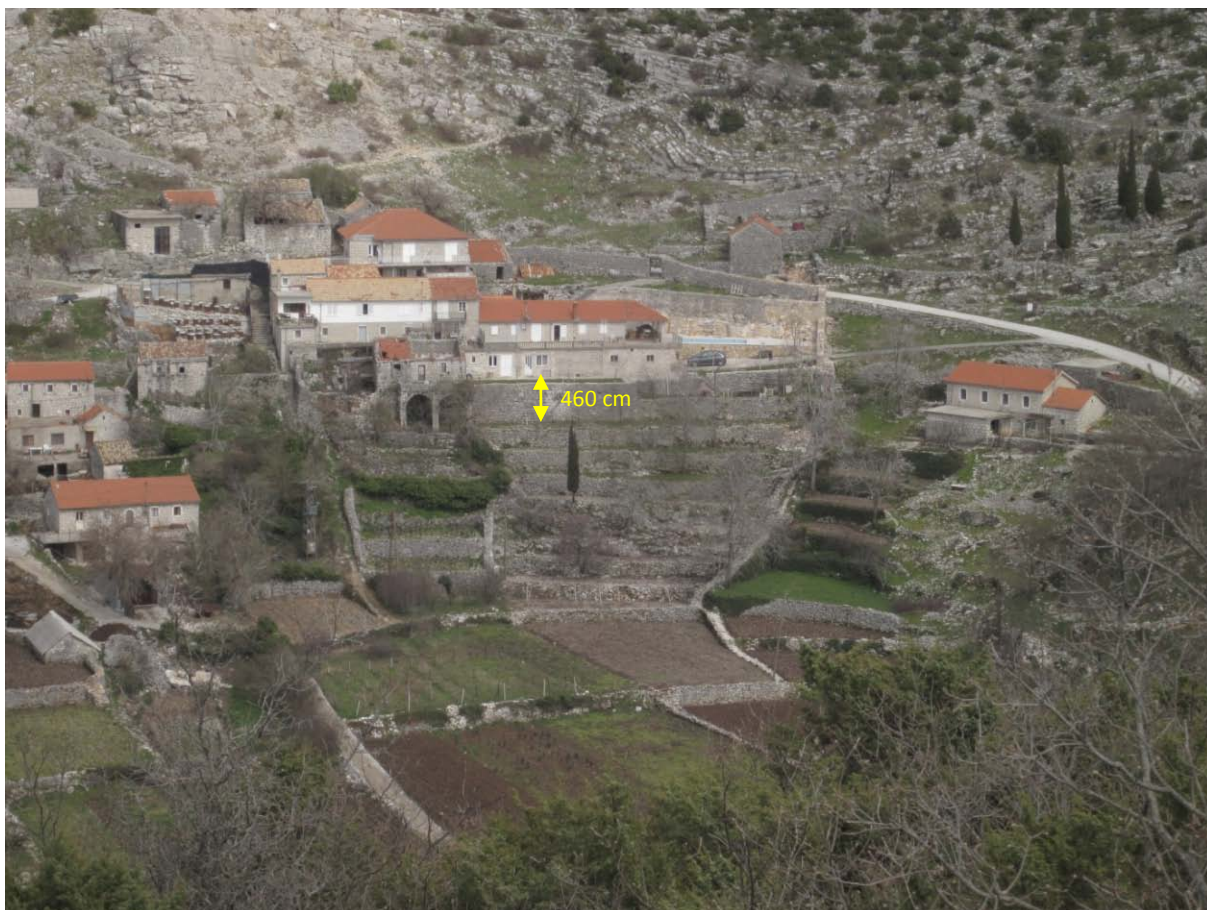
Slika 9.2.1.8. Od najvišeg podzida, koji iznosi 460 cm, se ostalima smanjuje visina prema njivama
