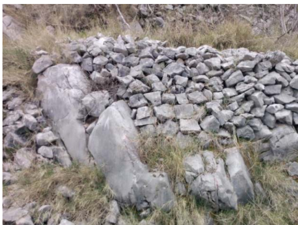
Slika 9.1.2.12. Interpolacija podzida na matičnu stijenu
