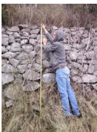
Slike 9.1.2.14. i 9.1.2.15. Najviše izmjereni zid na Osojniku iznosi 218 cm
