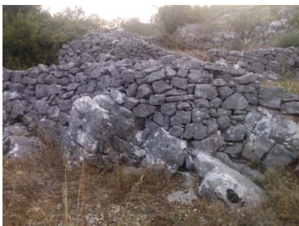
Slika 9.3.1.8. Interpolacija podzida na matičnu stijenu
