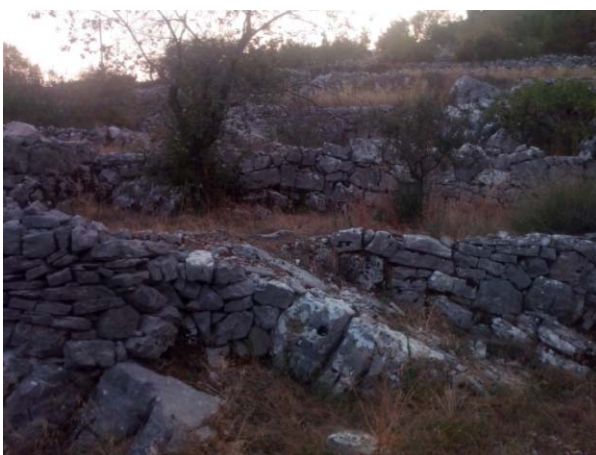
Slika 9.3.1.9. Iskorištavanje postojeće stijene za svladavanje visinske razlike među terasama
